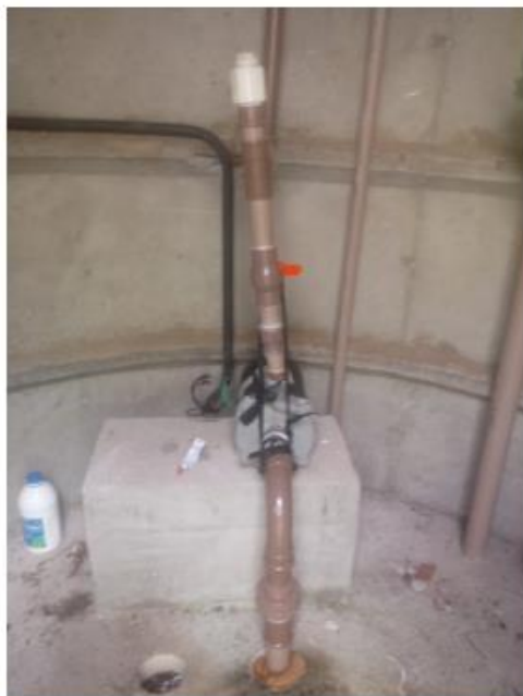
Imagem 2 e 3 – Troca da Tubulação na bomba de alimentação da caixa d'água
