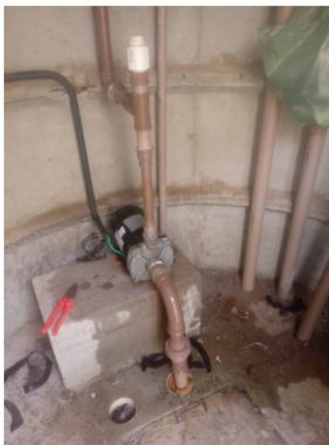
Imagem 2 e 3 – Troca da Tubulação na bomba de alimentação da caixa d'água
