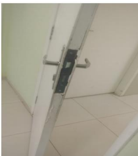
Imagem 12 e 13 – Troca de fechadura danificada por nova
