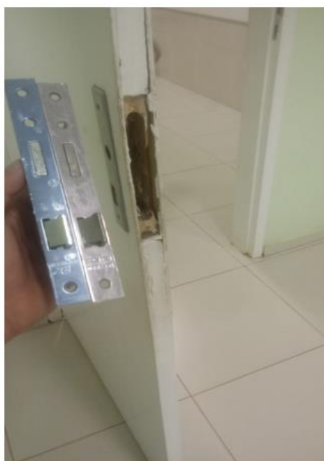
Imagem 12 e 13 – Troca de fechadura danificada por nova
